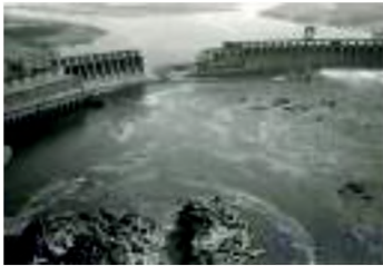
Іл. 42.8. Зруйнована вибухом гребля Дніпрогесу в 1941 р.
